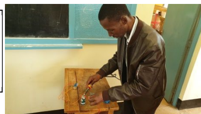
Die Anschlussdrähte für die Trockenbatterien wurden vorher mit einem Klebeband befestigt, jetzt kann der Physiklehrer diese mit dem neuen Lötkolben anlöten, so dass ein fester Kontakt gegeben ist.
